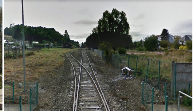
3. Franja Estación de trenes. Vista hacia el oriente desde calle Estación. Evidente dejo de mantenimiento y sensación de soledad.
