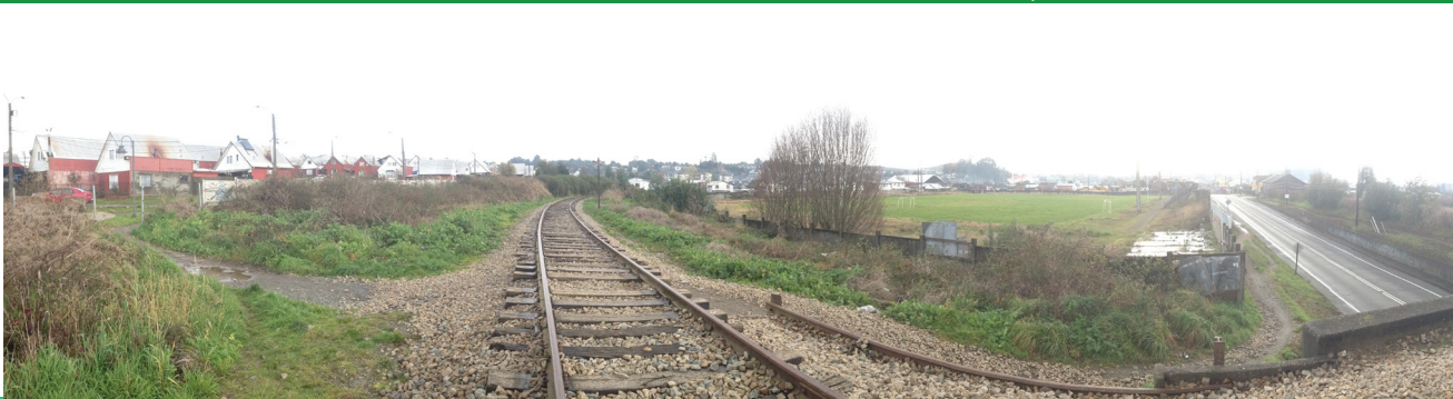
16. De izquierda a derecha, se observa el cruce informal que pasa desde la población y bordea el estadio para llegar a San Francisco, vía de acceso a la ciudad, que lleva al sector centro. Vista nor-poniente.
