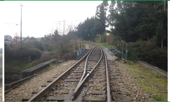
17-18. Puente donde termina el catastro. Izquierda: terreno privado; derecha: club de cabalgata privado. Vista al oriente.
