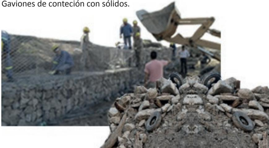
Estas terrazas generadas con los movimientos de tierra, se contendrán con gaviones de contención modulados, para facilitar su trabajo y poder realizar un diseño más flexible en su composición. Estos serán elaborados con los mismos bolones y sólidos clasificados anteriormente, de manera de depositarlos dentro de una malla acma, para así generar un bloque.
