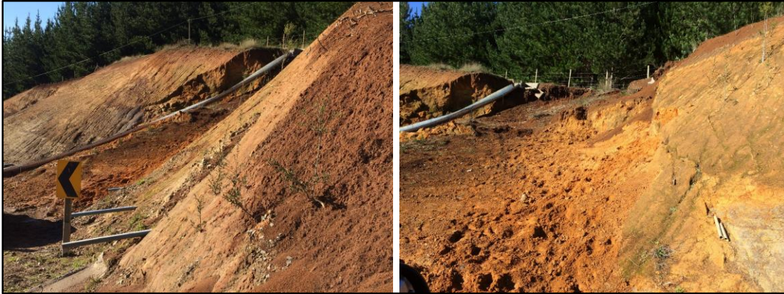
Figura 10: (a) Vista lateral del talud. (b) Vista Frontal del talud.
