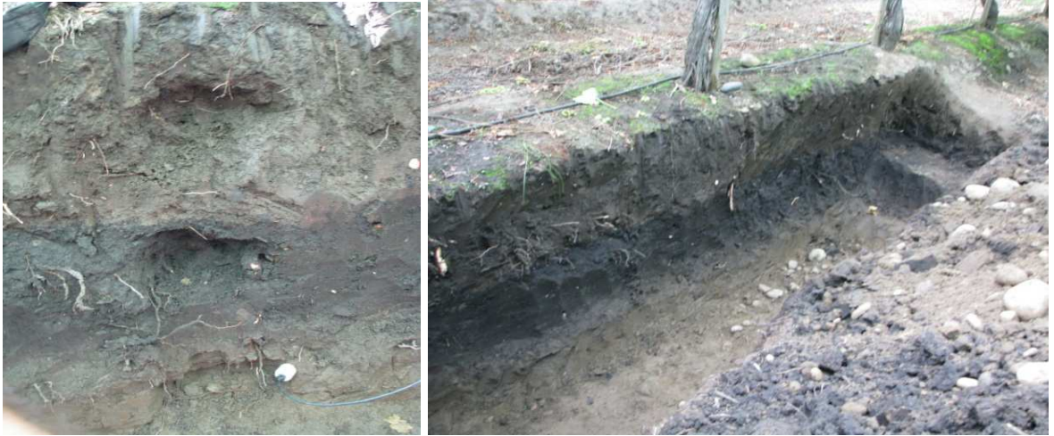
Figura 16. Visualización del perfil modal (Calicata 2) de cuartel N°6 de la variedad Red Globe.
