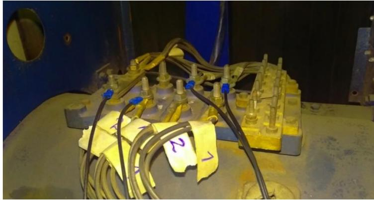
Figura 22: Bornes exteriores del generador síncrono.
