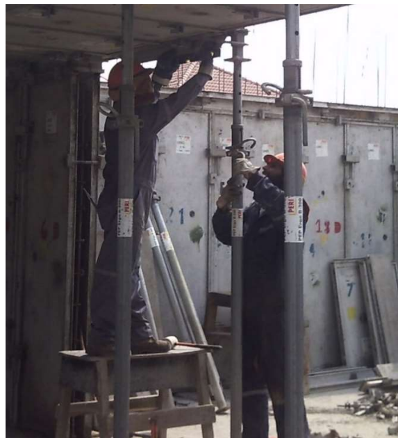
Imagen 14: Tarea de Montaje de Paneles de Losa por dos Maestros de Primera.
