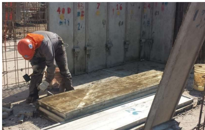
Imagen 26: Tarea de Limpieza de Piezas de Moldaje por Maestro de Primera.
