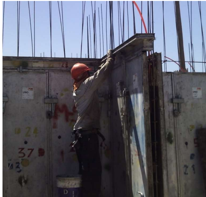
Imagen 13: Tarea de Montaje de Paneles de Losa por un Maestro de Primera.
