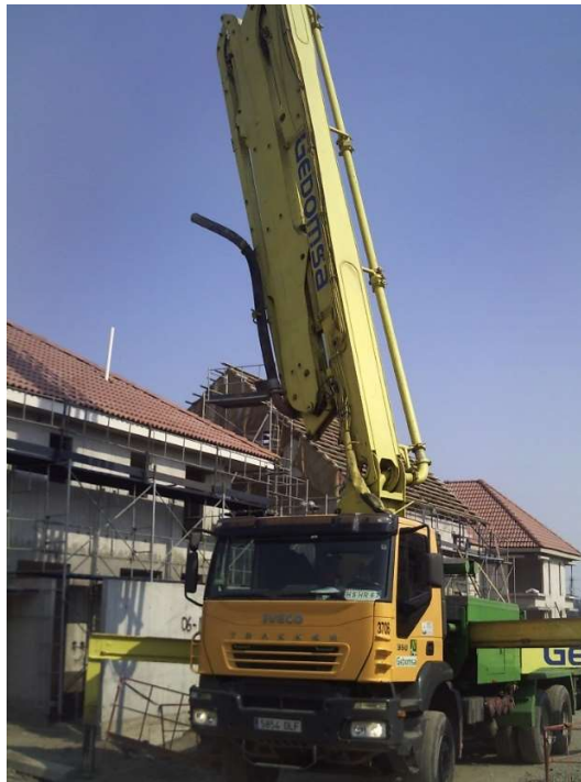
Imagen 16: Bomba Telescópica utilizada para el Vertimiento de Hormigón.
