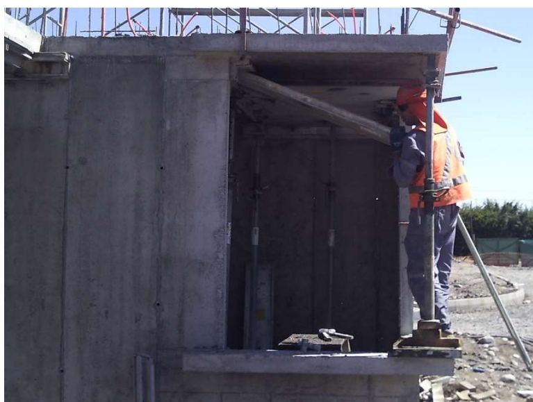
Imagen 22: Tarea de Descimbre de Paneles de Losa por Maestro de Primera.
