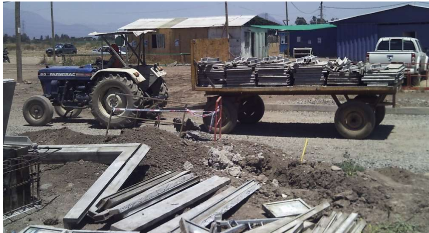
Imagen 24: Tarea de Transporte de Piezas de Moldaje por Tractor y Carro Coloso.
