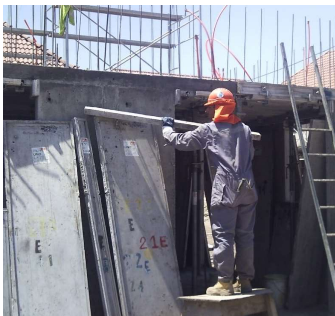
Imagen 19: Tarea de Descimbre de Paneles de Piezas Especiales por Maestro de Primera.
