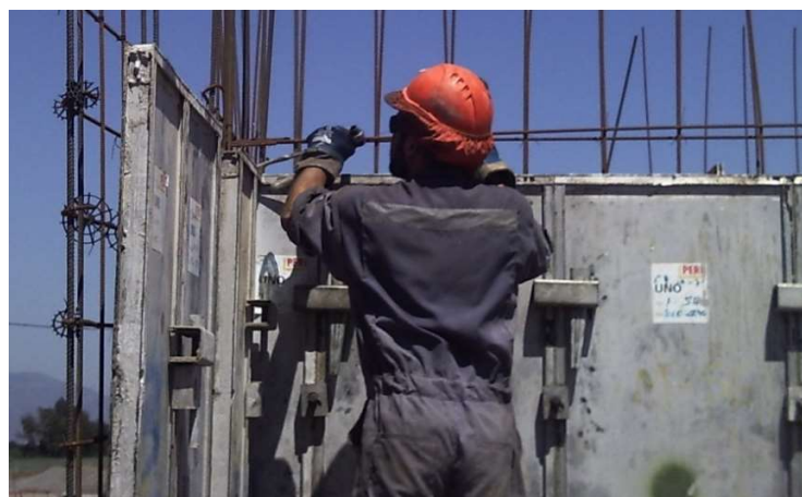
Imagen 27: Tarea de Limpieza de Piezas de Moldaje por Maestro de Primera.
