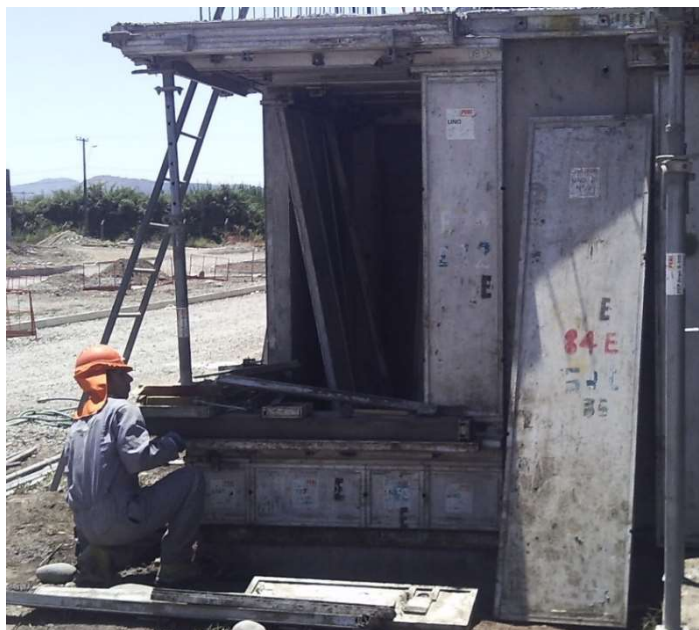
Imagen 18: Tarea de Descimbre de Paneles de Piezas Especiales por Maestro de Primera.
