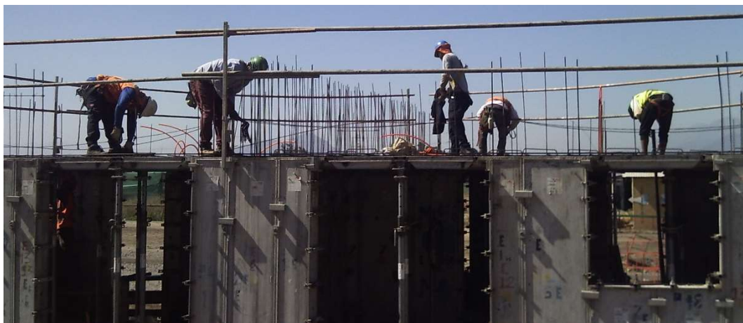
Imagen 15: Tarea de Montaje de Enfierradura de Losa por Cuadrilla de Enfierradores.
