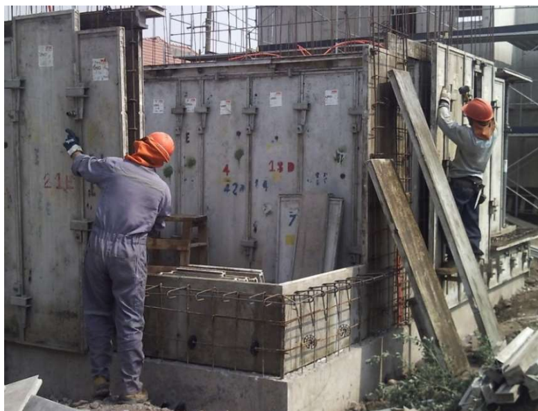
Imagen 10: Tarea de Montaje de Paneles de Muro Exteriores por dos Maestros de Primera.
