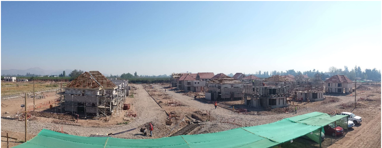
Imagen 4: Vista Panorámica de la Obra “Conjunto Habitacional Buin/Villaseca”.
