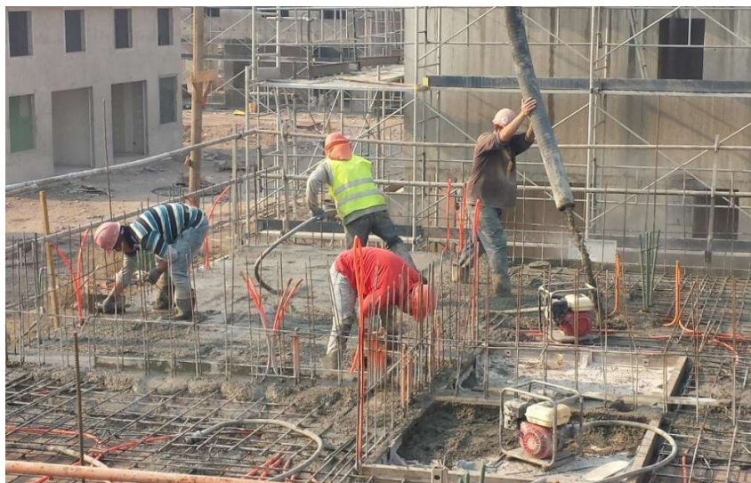
Imagen 17: Tarea de Hormigonado por Cuadrilla de Concreteros.
