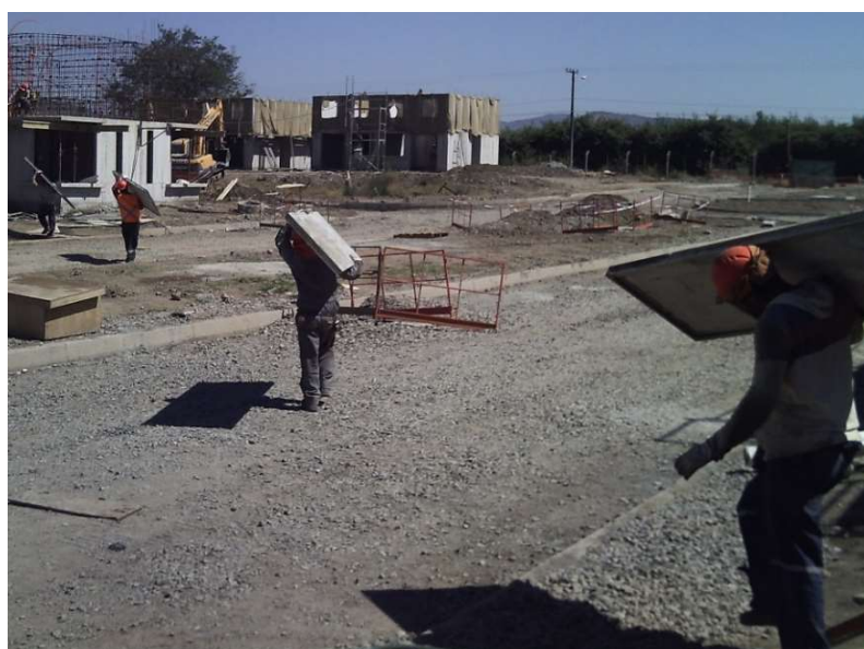
Imagen 23: Tarea de Transporte de Piezas de Moldaje por Cuadrilla de Moldajeros.
