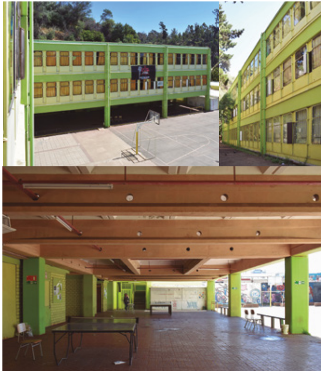
Figura 10 Instituto Superior de Comercio Blest Gana, Viña del Mar. Tipo 520 hormigón prefabricado. Fuente: Fotografías de Claudia Torres.
