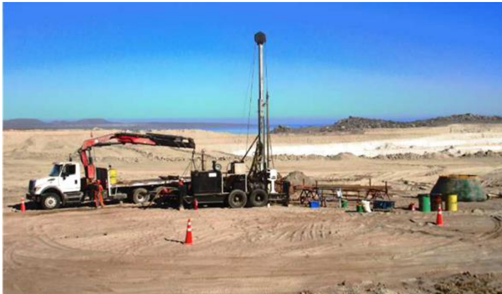
FIGURA 4.2 MONTAJE SONDAJE SC-02
