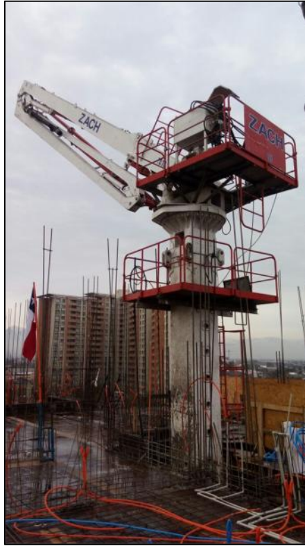
Figura 7: Torre de distribución de Hormigón utilizada en la obra.
