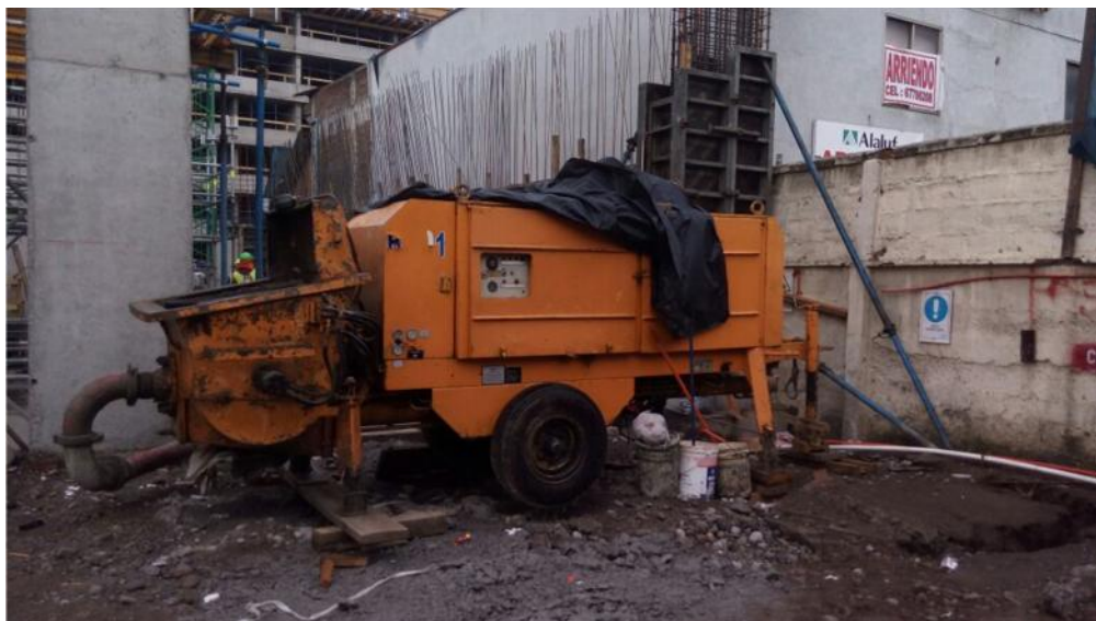
Figura 4: Bomba de hormigón utilizada en la Obra.
