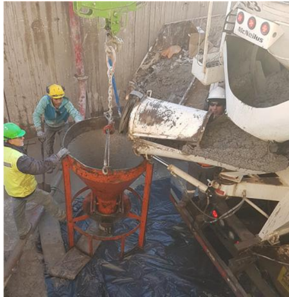
Figura 5: Hormigonado con Capacho.
