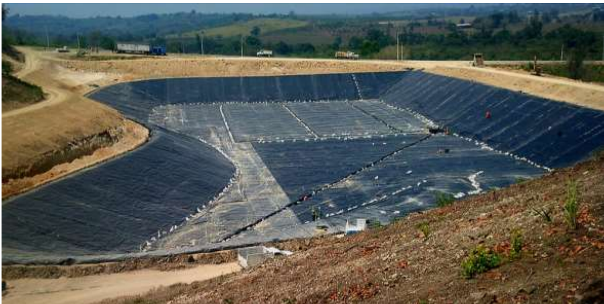
Ilustración 10 Membrana impermeable, vertedero (Fuente: http://www.georigo.com/?mod=galeria )
