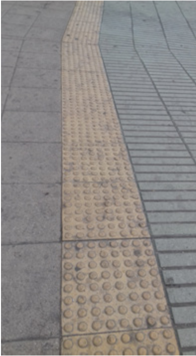
Foto 24. Huella podoáctil calle
