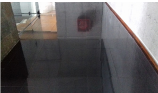
Foto 36. Desnivel solucionado con rampa de mínima pendiente
