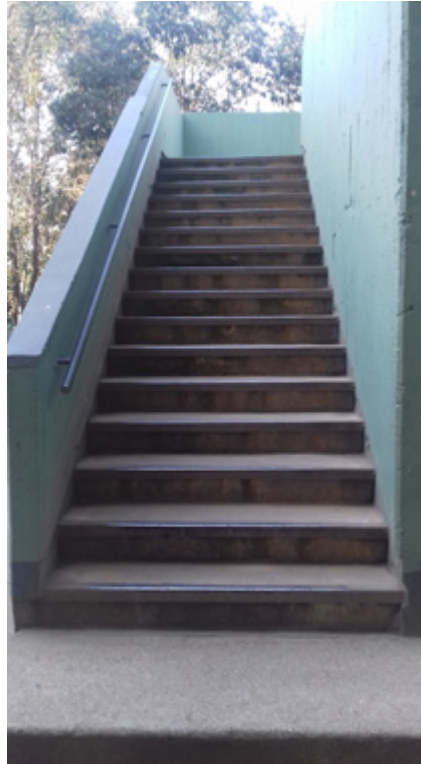
Foto 33. Escalera como único acceso
