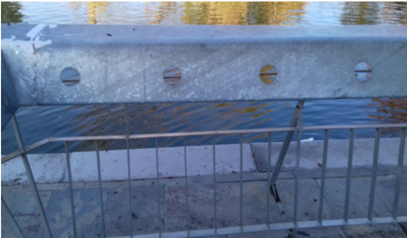
Foto 34. Detalle de baranda
