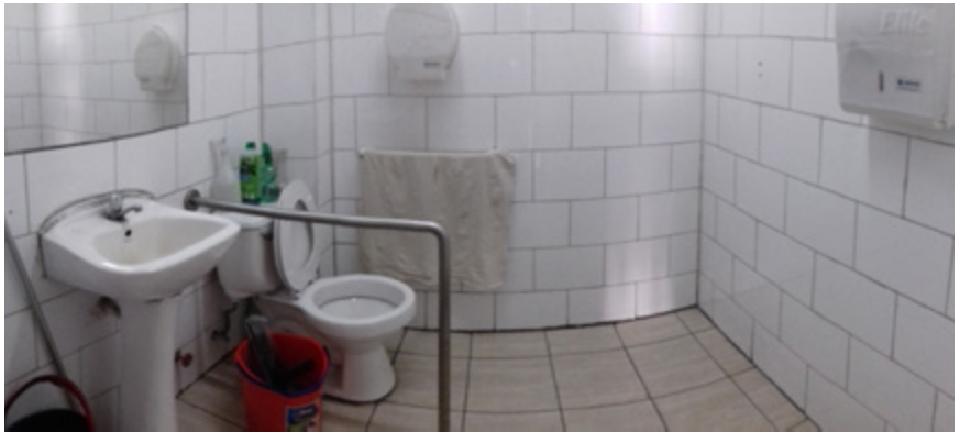
Foto 42. Vista panorámica baño para personas con discapacidad
