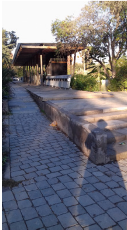
Foto 25. Ejemplo de rampa sin pavimento táctil y superficie no lisa en comienzo
