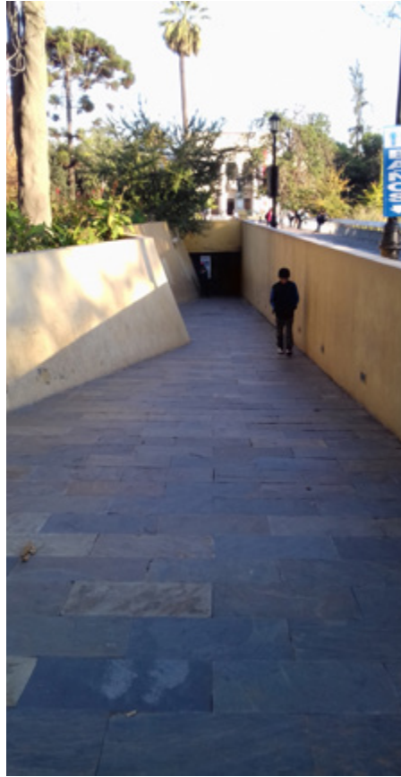
Foto 6. Rampa de acceso a baños públicos
