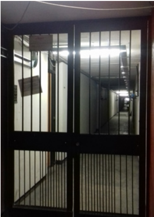
Foto 15. Ejemplo de vano y pasillo
