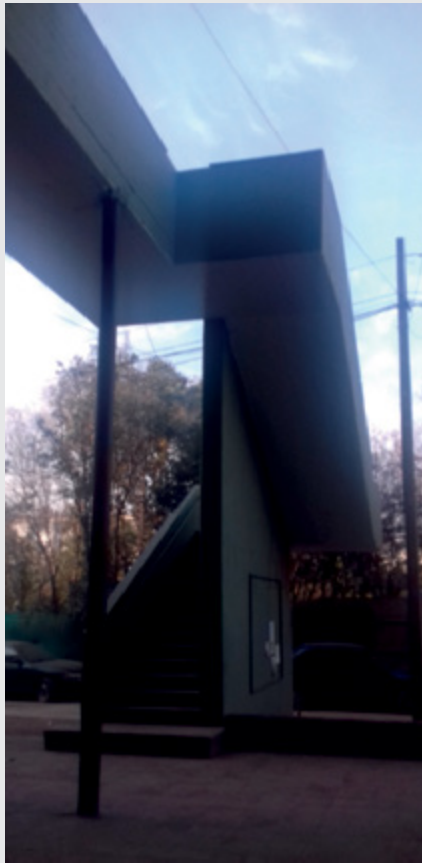
Foto 8. Escalera como único acceso
