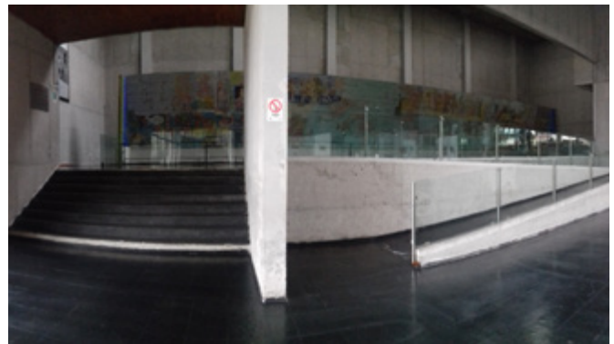
Foto 32. Rampa como alternativa a escaleras
