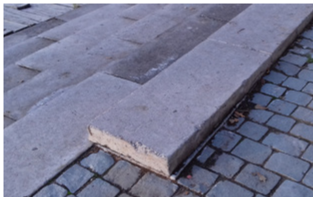
Foto 2. Escaño no señalizado sobresaliente en acceso a muelle
