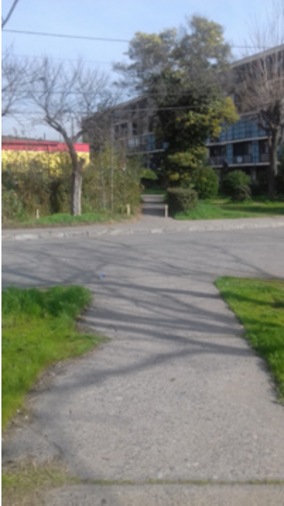
Foto 19. Cruce no señalizado y sin rebaje
