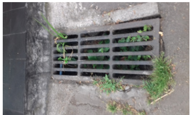
Foto 27. Rejilla de agua zona trasera
