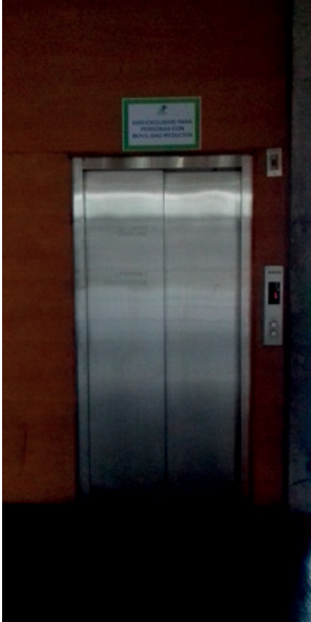
Foto 7. Ascensor exclusivo para personas con discapacidad
