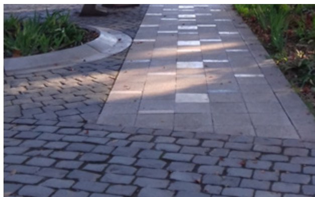
Foto 2. Escaño no señalizado sobresaliente en acceso a muelle
