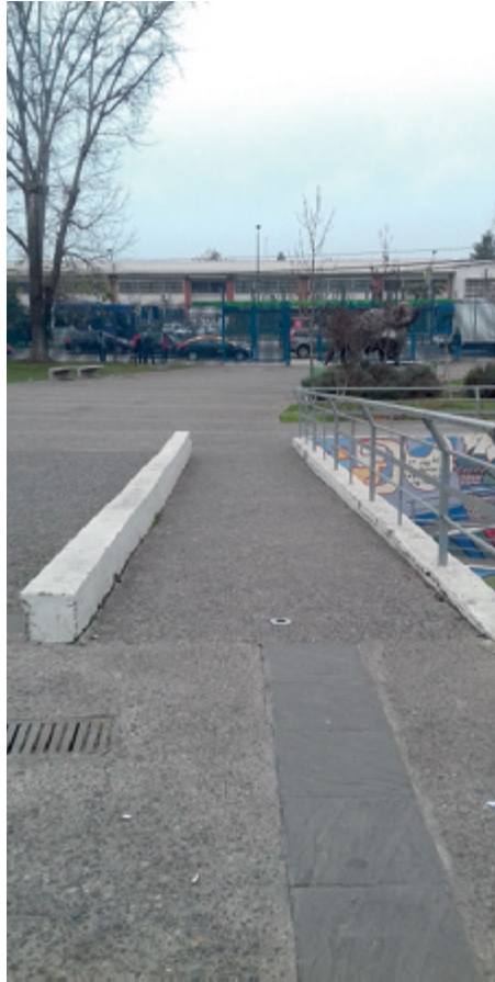
Foto 5. Rampa de acceso entrada
