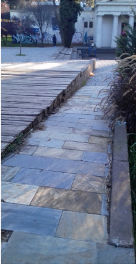
Foto 5. Rampa de acceso zona laguna
