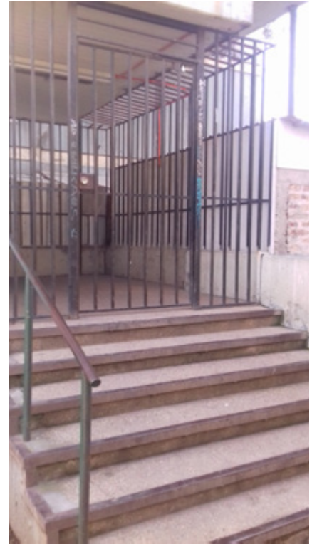
Foto 34. Escalera como único acceso
