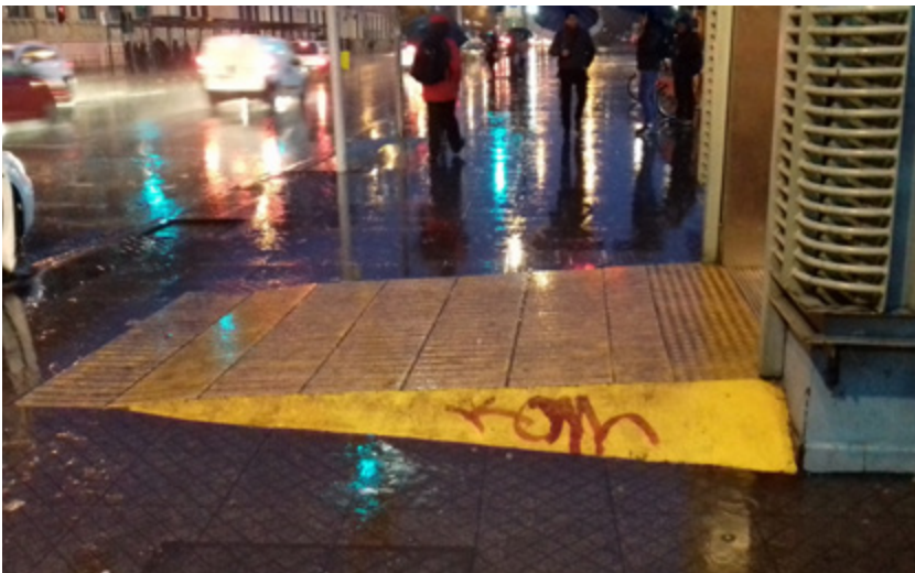
Foto 39. Ejemplo de rampa según recomendación. Salida ascensor Metro Quinta Normal
