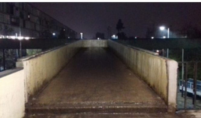
Foto 35. Pasarela sin baranda, con escaño no señalizado y piso en mal estado
