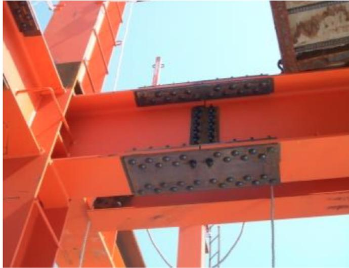
Figura 2.2: Ejemplo de conexión “Column-Tree” mediante pernos (Fuente: Keunyeong Oh 2015)
