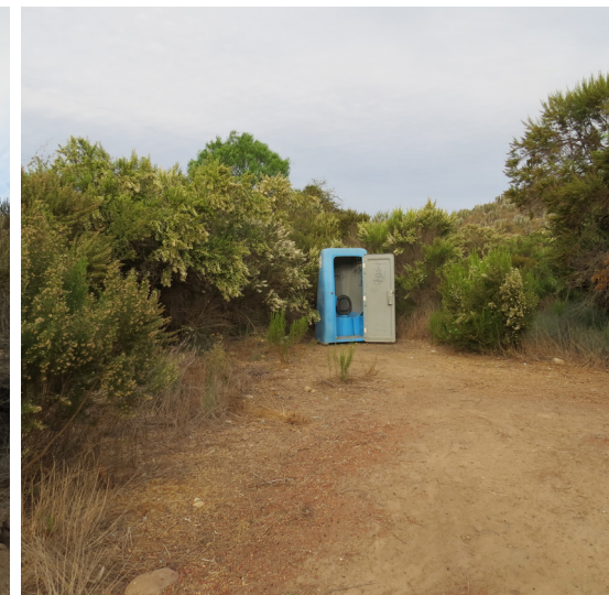
Fotografía n°8, Inexistencia de Infraestructura de servicios. Fuente: Autoría propia
