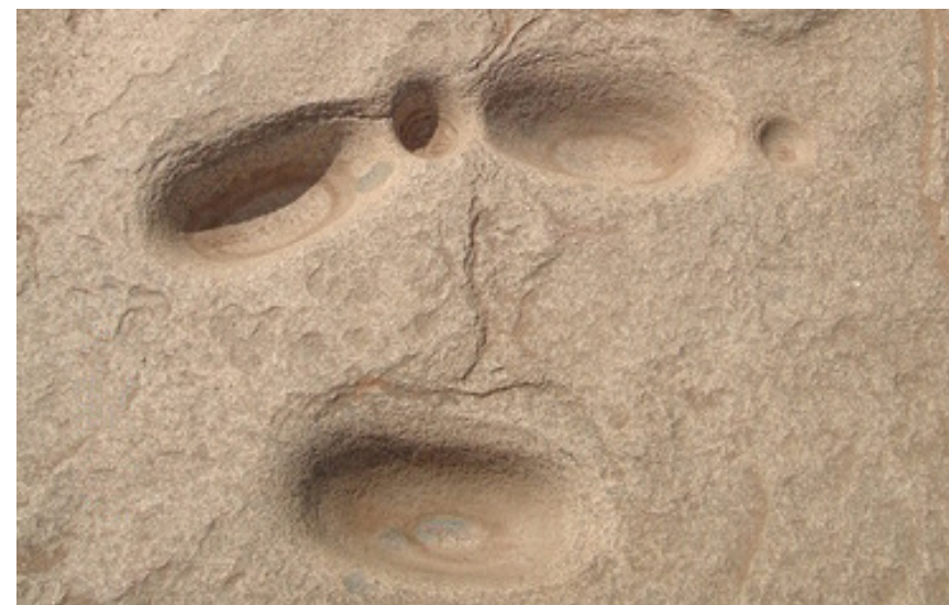
Fotografía n°30, PIEDRA DEL DIABLO Fuente: Autoría propia
