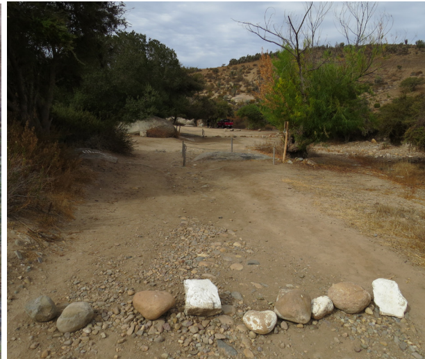
Fotografía n°4, Deficiente solución de protección de piedra tacita por el camino vehicular. Fuente: Autoría propia
