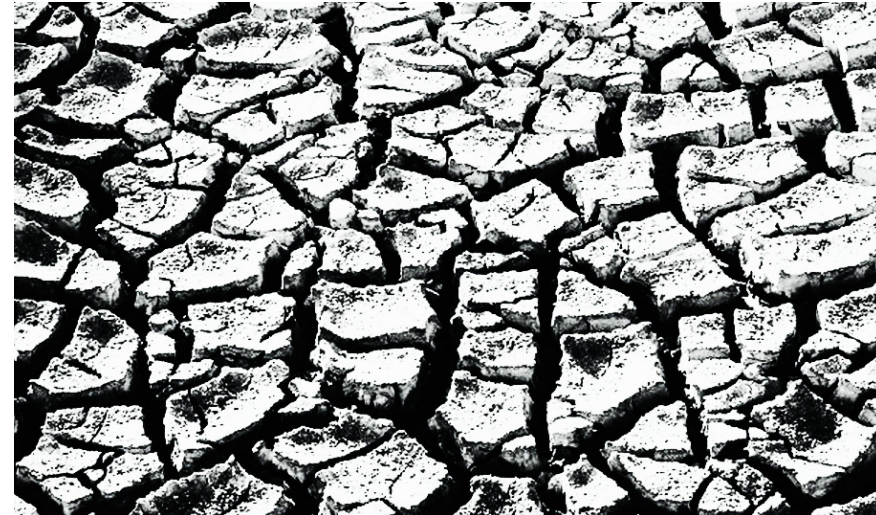
Figura N°18, GRIETAS EN LA TIERRA Fuente: Elaboración propia
