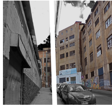
Edificio nave central ex fábrica
