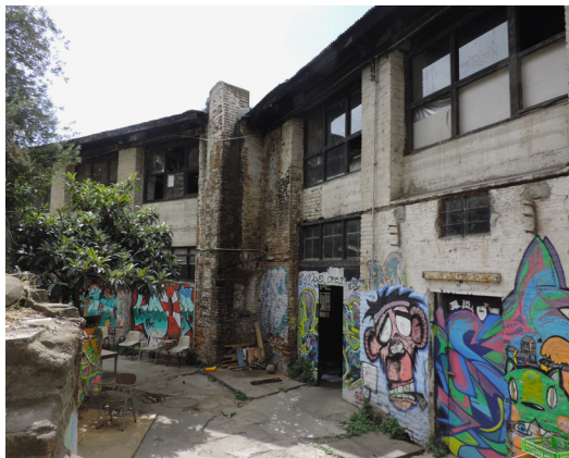
Vista desde patio interior. Fuente: Elaboración propia.
