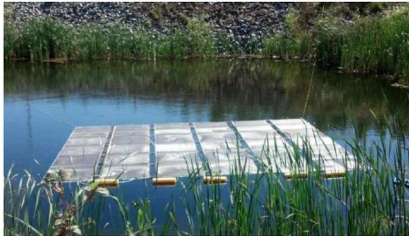
Figura 4.5 PV flotantes directamente sobre agua. Fuente: [8]
