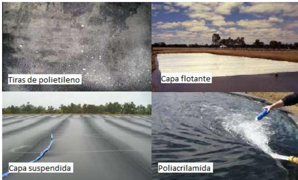
Figura 2.10 Los distintos tipos de disminuir la evaporación. Fuente: [5]
