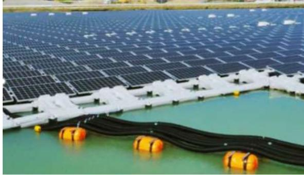
Figura 4.4 PV sobre flotadores. Fuente: Kyocera Solar
