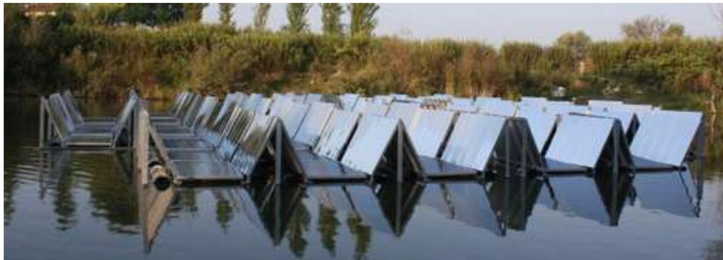
Figura 4.9 Planta piloto con concentración fotovoltaica y seguimiento solar. Fuente: SCINTEC.
