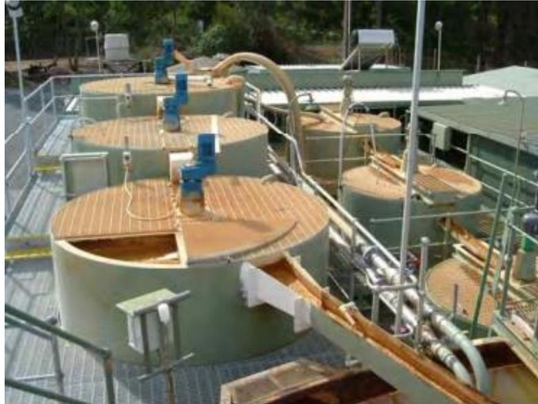
*Figura 2: Planta HDS, utilizando maquinaria y un input de energía importante Fuente: Taylor et al, 2005.*
