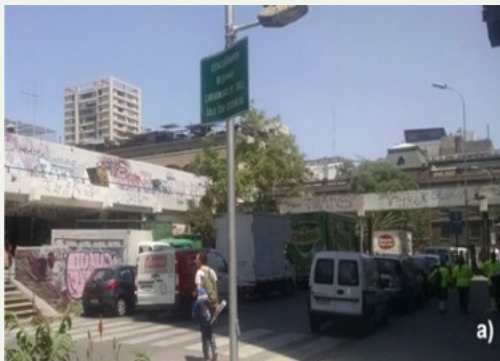
Pasarela sobre la calle Carabineros de Chile
