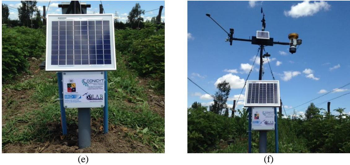
Figura 8. Construcción e instalación del prototipo: (a) Estructura, (b) circuitos, (c) ensamble del prototipo, (d) instalación sensor VH400-2 bajo 0,05 m de la superficie del suelo, (e) sistema low-cost instalado (f) sistema low-cost y estación LAB-net.
