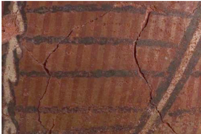
Figura 65.- Detalle de grietas por deplacamiento en cuerpo de la pieza (Fotografía: L. Ormeño 2016, Archivo CNCR).
