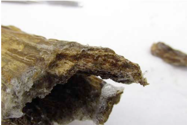
Figura 235.- Detalle de superficie en punto de unión antes de la limpieza. (Fotografía: M. Dinator, 2017. Archivo CNCR).
