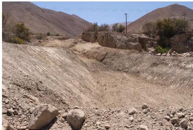
Figura 3-11. Arriba: Canal creado para la desembocadura de la quebrada Los Loros, con área urbana asociada, luego del evento. Centro: Poblado de San Antonio al final de la quebrada homónima, con el material del flujo removido. Abajo: Desembocadura de quebrada Lautaro, que queda al este del tranque Lautaro, donde el material ha sido removido, y se aprecian depósitos dejados por el flujo,
