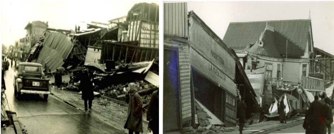
Figura 7.42: Calle Picarte (Fuente: Gentileza Grupo Terremoto Valdivia).
