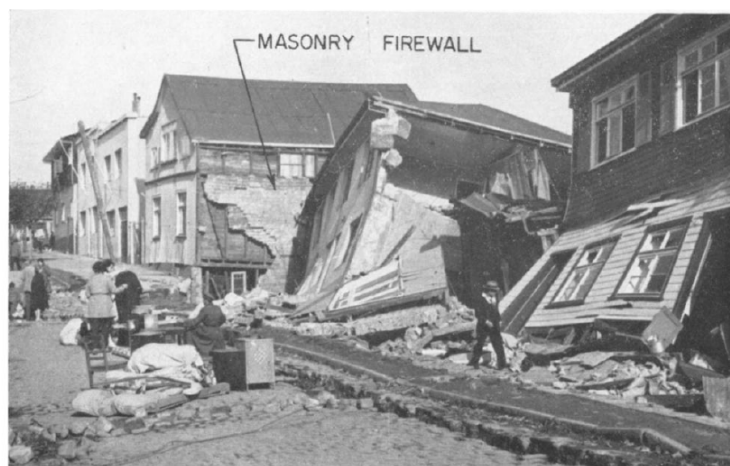
Figura 7.14: Daños a viviendas de madera a lo largo de una zona llena de tierra de la calle García Reyes en Valdivia. Se pueden observar los cortafuegos de mampostería entre los edificios de armazón de madera (Fuente: Steinbrugge y Flores, 1963).
