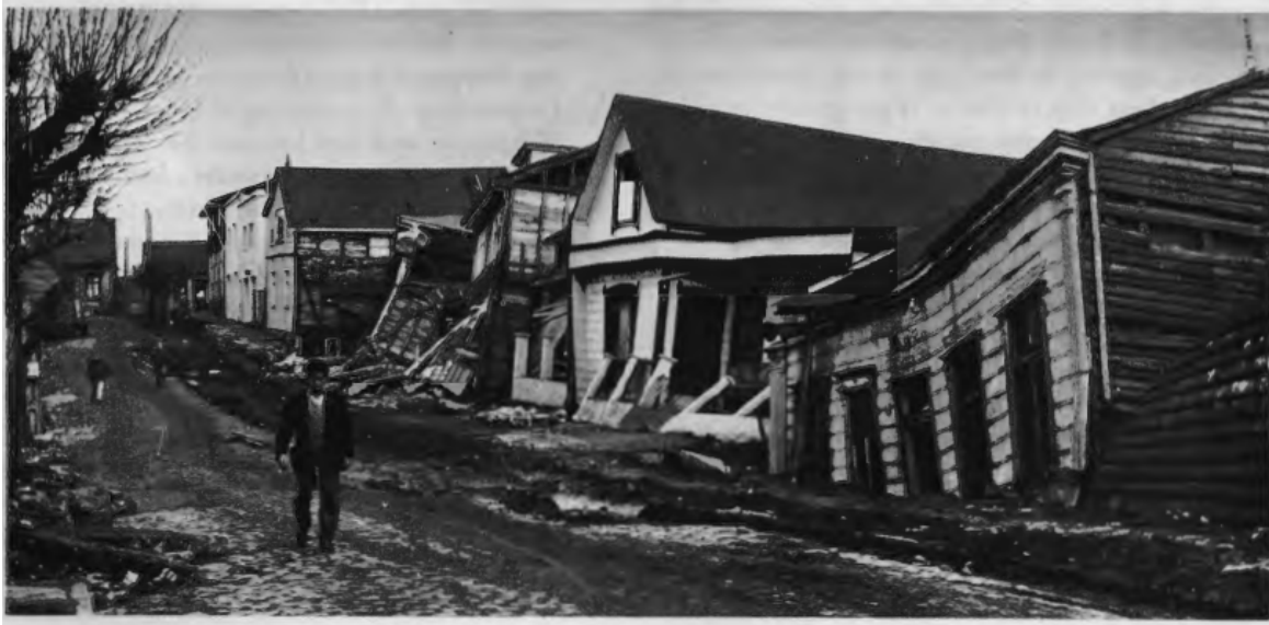
Figura 3.5: Calle García-Reyes afectada por grandes asentamientos. (Saint Amand, 1961)
