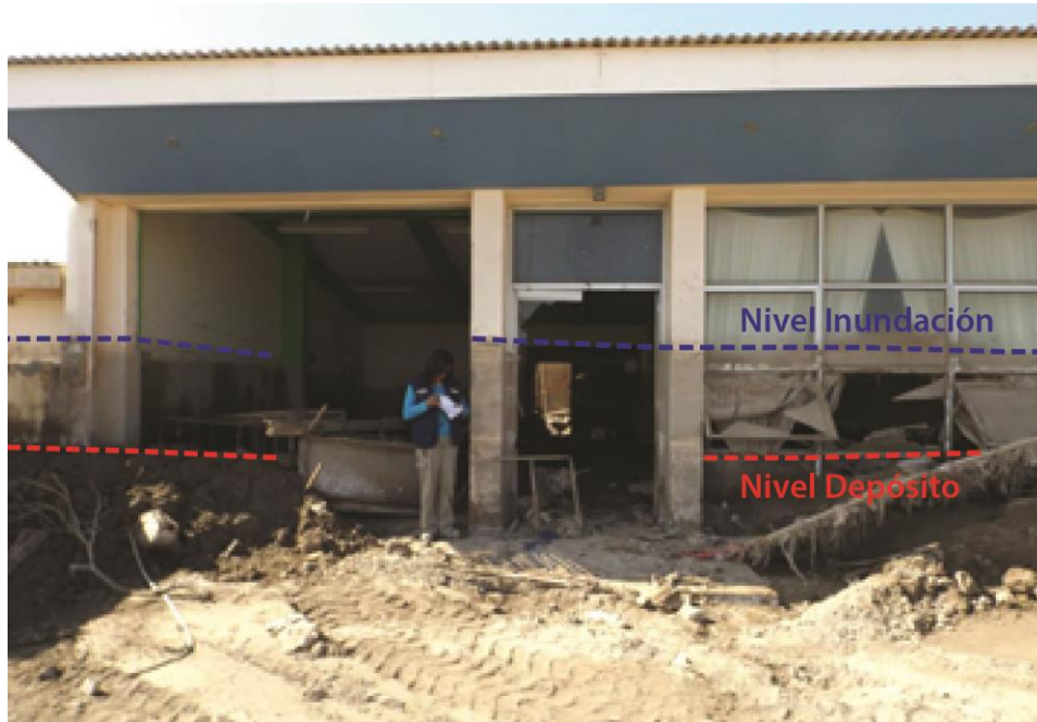
Figura 10: Imagen que muestra la metodología de cómo se tomaron los datos de altura de inundación y depósito.
