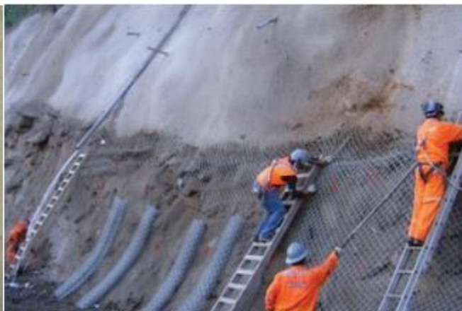
Figura 2: Hormigón proyectado para estabilidad de taludes
