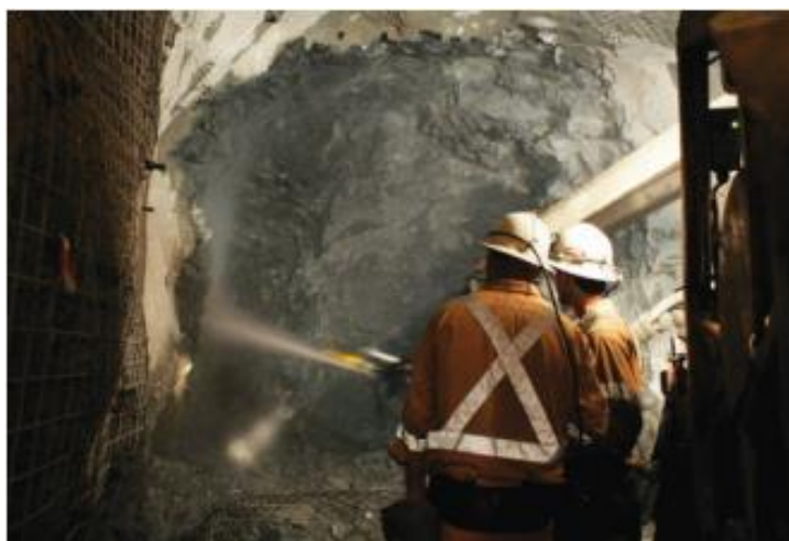
Figura 3: Hormigón proyectado como soporte permanente de túneles
