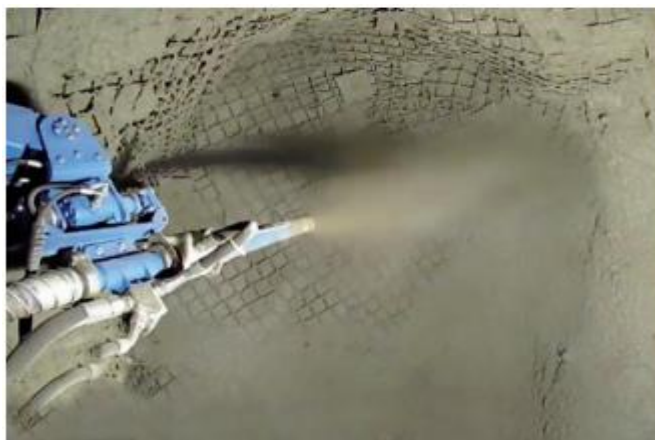
Figura 1: Hormigón proyectado sobre malla y perno, para faenas mineras subterráneas
