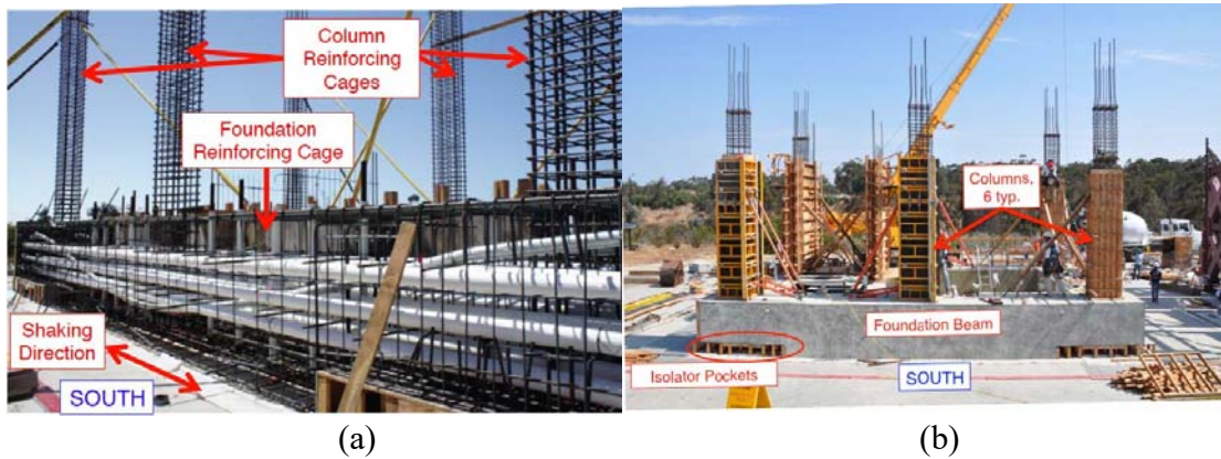
Figura 6.3: Fundación durante la etapa de construcción: (a) armadura de refuerzo ductos de post-tensado. (b) vista sur de la fundación después de concretar. Fuente: (Chen, et al., 2016).
