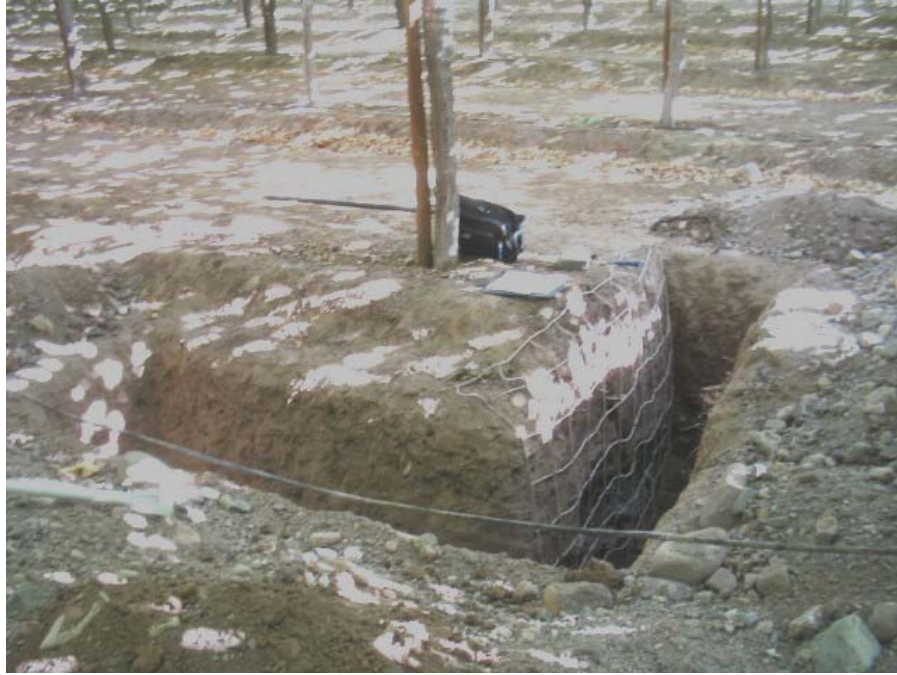
Figura 1. Ubicación de la calicata frontal y lateral en torno a la planta.
