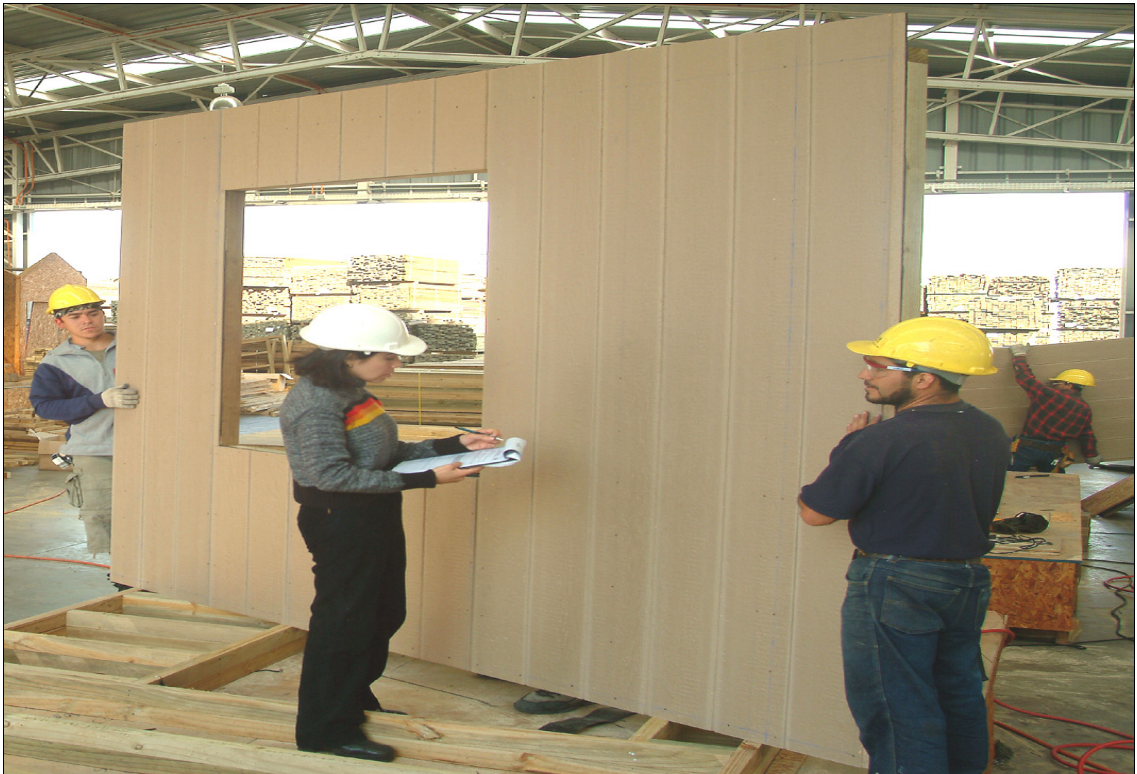
Figura 3.27: Inspección de calidad de los elementos industrializados de las viviendas sociales SCMI
