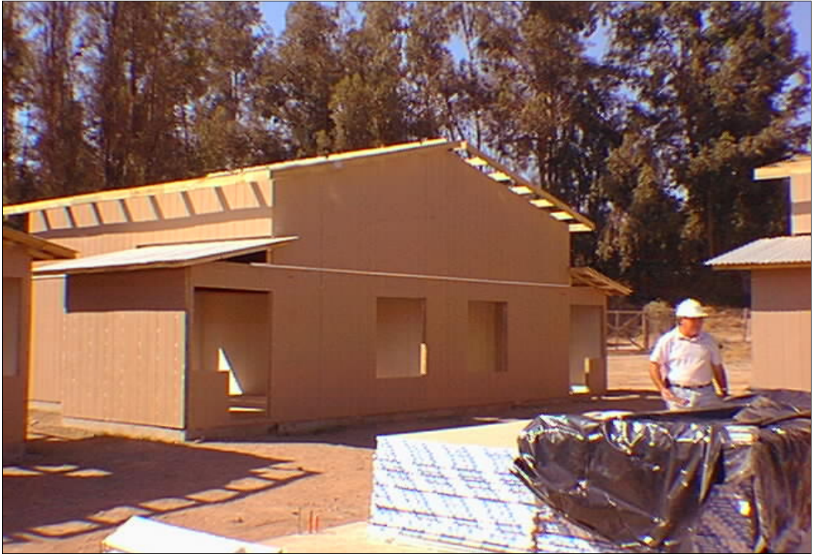
Figura 2.2: Montaje de los elementos industrializados de las viviendas sociales SCMI en el lugar de emplazamiento
