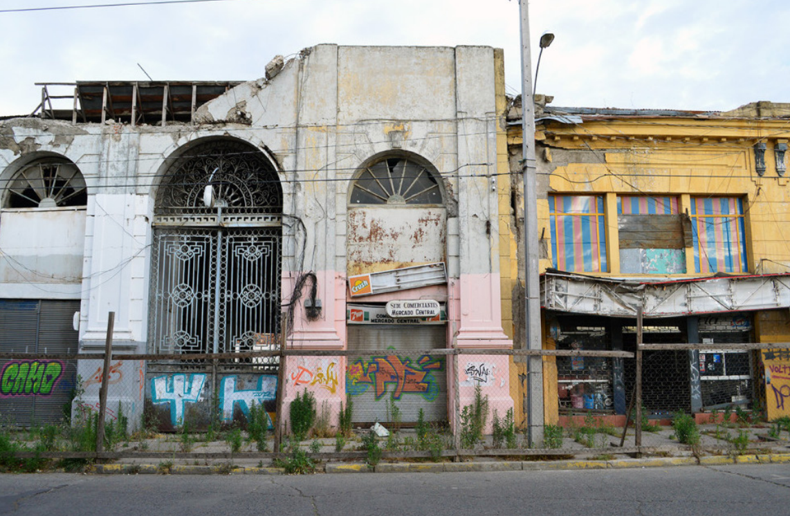
Imagen 3.2-11 Mercado de Talca dañado por el terremoto de 2010.
