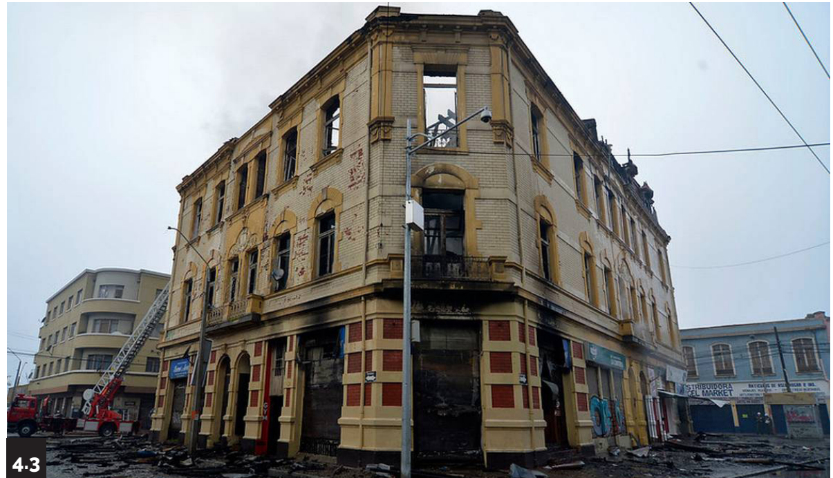
4.3. Edificio patrimonial incendiado Abril 2017
