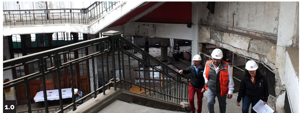
1.0- Autoridades de la región de Valparaíso y el Mercado Puerto, en el marco del inicio a las obras, de rehabilitación. Fuente: http://biobio-chile.cl
