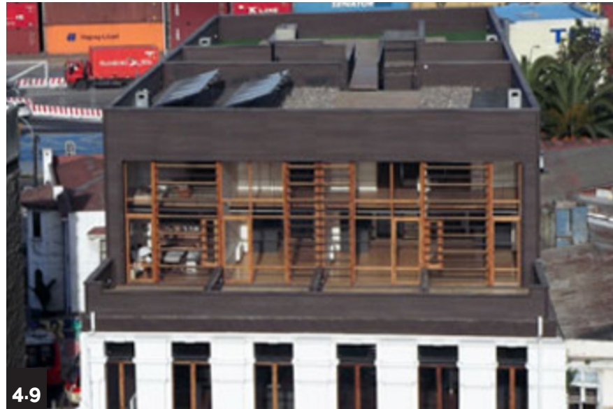
4.9. Ampliación edificio loft Aduana
