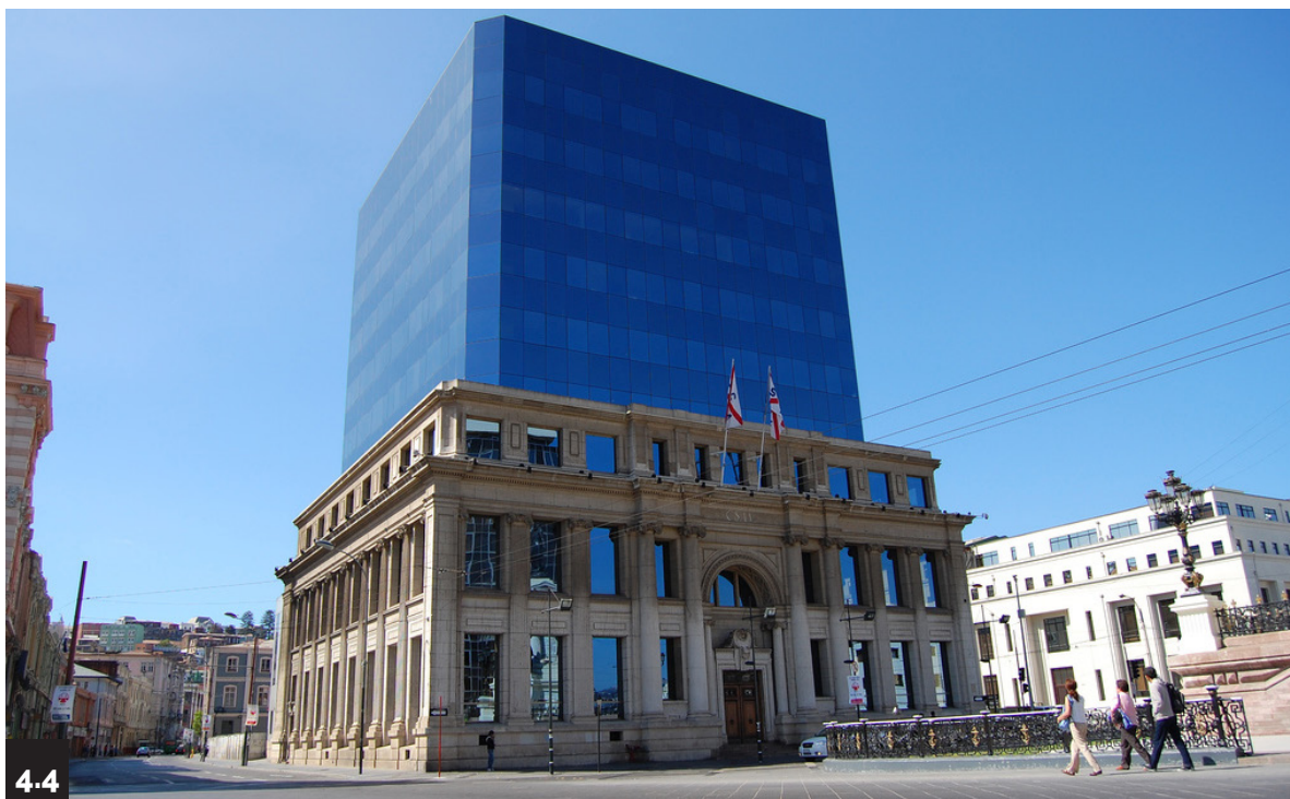
4.4. Edificio de la Sudamericana de Valpores rehabilitado en la década del 90
