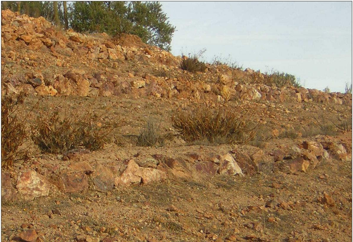
Figura 24. Muro de piedra.
