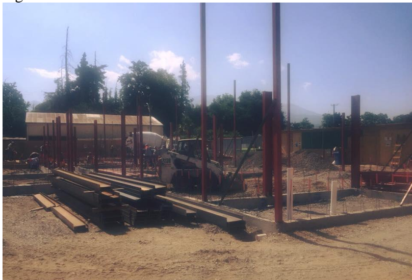
Figura 3.2: Avance constructivo a la fecha del contrato Torunos
