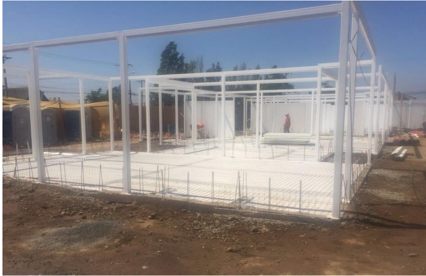
Figura 3.4: Avance constructivo a la fecha del contrato La Gamboina
