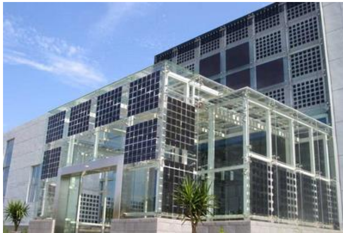
Figura 5. Fachada con láminas fotovoltaicas sobre vidrio en España. Fuente: Google, (2015).
