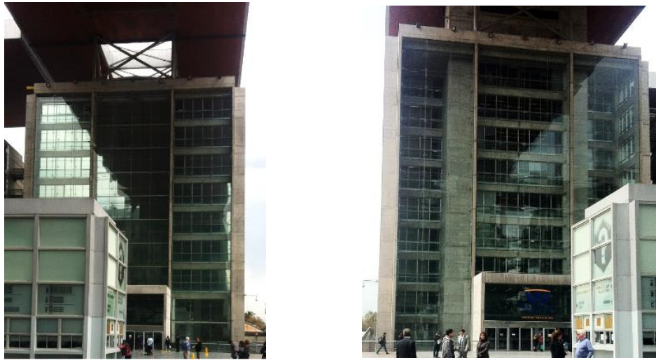
Figura 15. Arriba, ventanas cubiertas de cristales de los edificios de Defensoría (izquierda) y Fiscalía (derecha).
