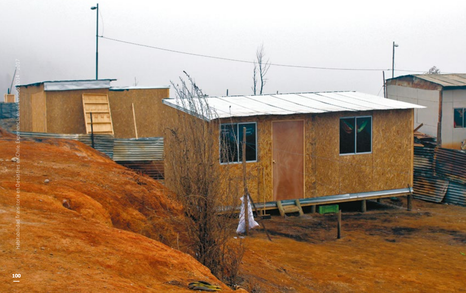
Conjunto de viviendas de emergencia Valparaíso 2014, Región de Valparaíso.
