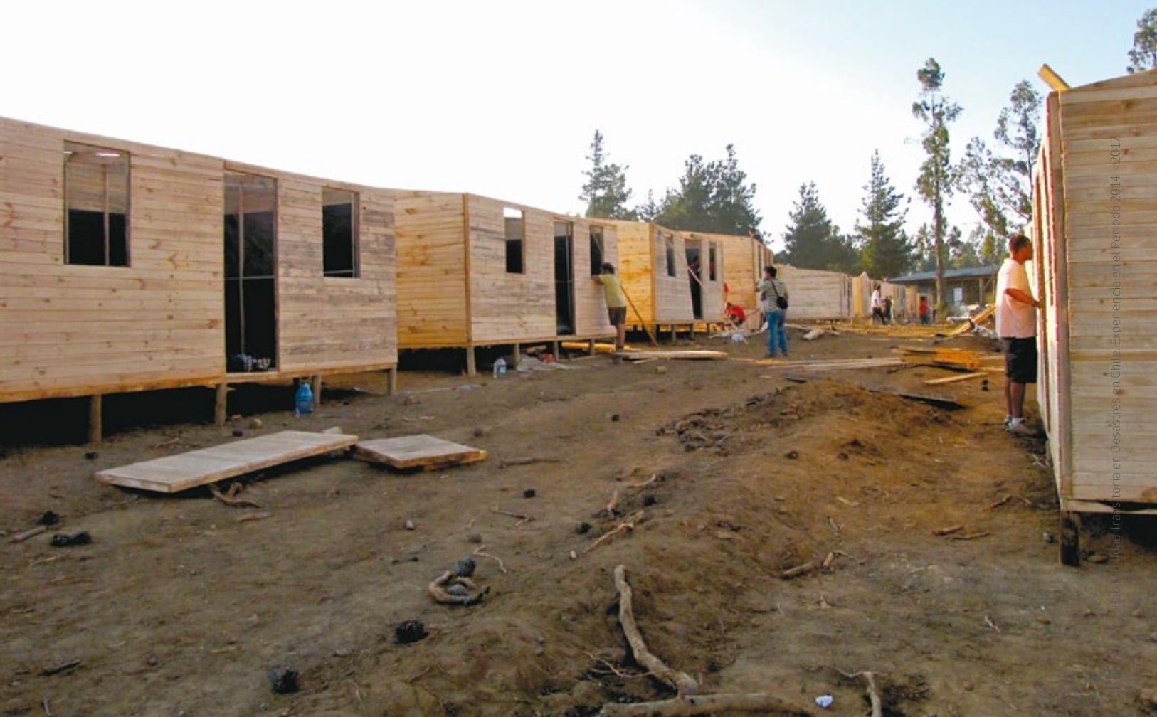
Construcción de viviendas de emergencia post terremoto 2010, Región del Biobío.
