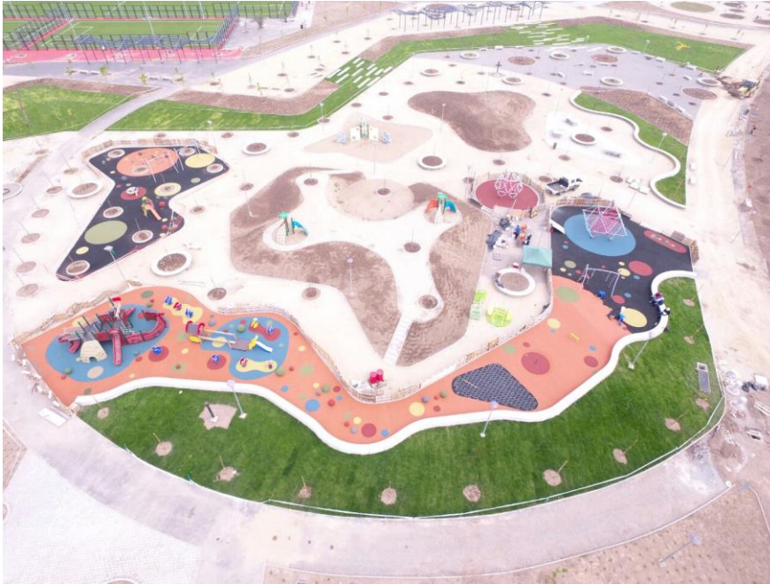
Figuras 16 y 17_ Vista aérea proceso de ejecución Parque Pierre Dubois.
