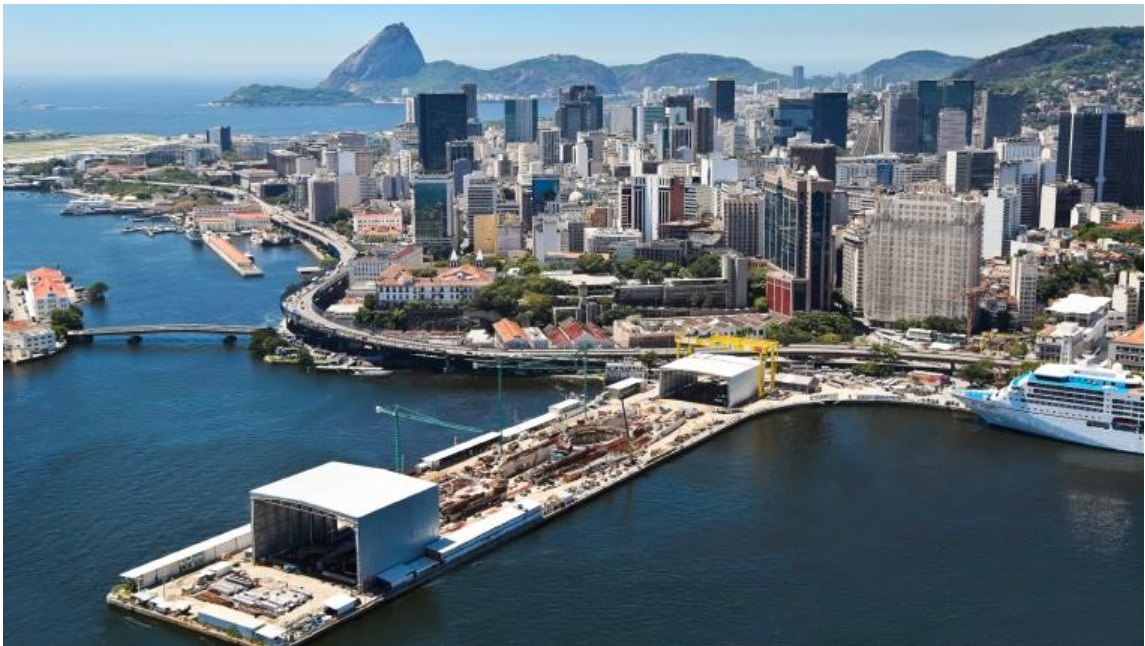
FIGURA 3-8: PANORÁMICA PUERTO MARAVILLA TRAS LAS INTERVENCIONES
