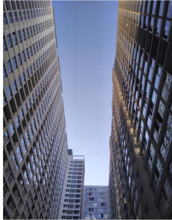
“Patio interior” Torre1 y Torre 2, Edificio Alameda Urbano
