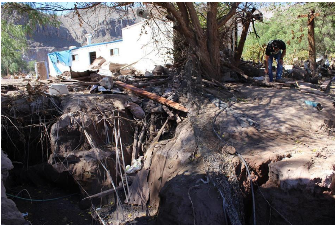
6. Campamento La Capilla sector sur-poniente, socavón dejado por el agua. Foto: Yoselin Fernández
