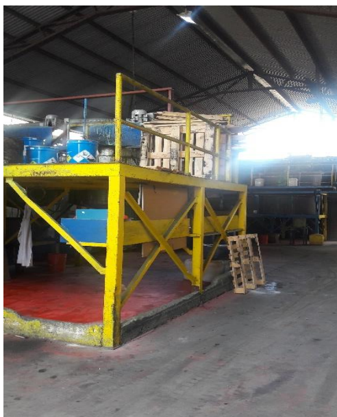
Figura 13: Área preservantes de madera
