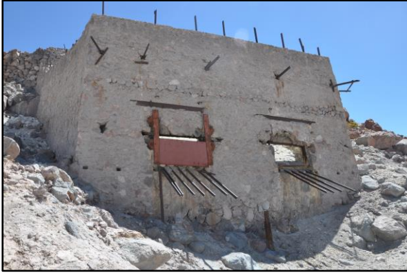
Ilustración 10: Compuertas del Bolsón, por donde caía el material de azufre para cargar el camión. Fotografía del autor, mayo 2015.
