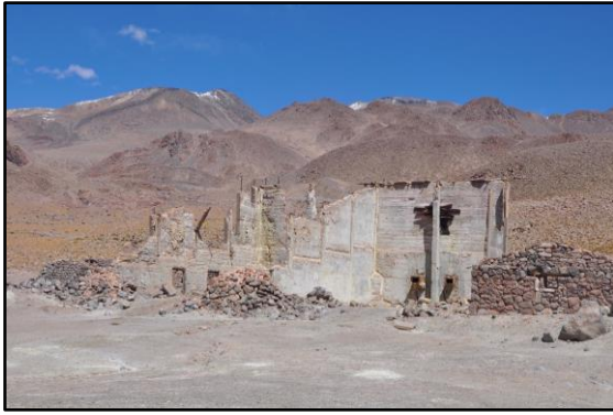
Ilustración 12: Muros que corresponden a la planta de refinamiento de Saciél. Fotografía del autor, enero del 2015.
