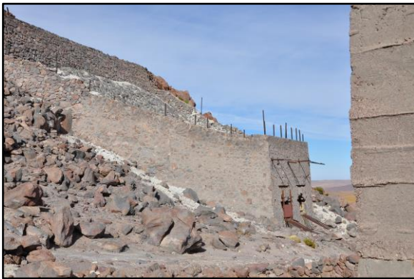
Ilustración 11: Bolsones correspondiente a la planta de Refinamiento de Saciel. Se aprecia la utilización de la pendiente tanto en el almacenaje del azufre, como en su posterior carga para traslado. Fotografía del autor, mayo 2015.
