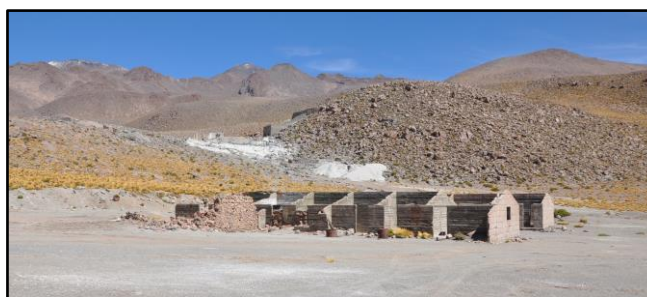
Ilustración 14: Edificaciones del Campamento Saciél, en este caso corresponde a las piezas de los mineros “solteros”. Fotografía del autor, marzo 2015.
