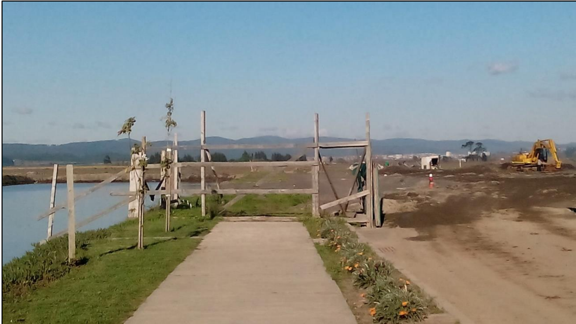
Figura N° 16. Última etapa de construcción proyecto San Marcos 2000 de Inmobiliaria Miramar. Fuente: Elaboración propia, 2016.
