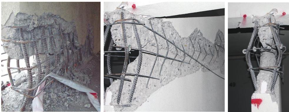
Figura 1: Pandeo de Armadura en muro de hormigón armado por flexo-compresión (Fuente: Mw=8.8 Terremoto en Chile, 27 de febrero 2010)
