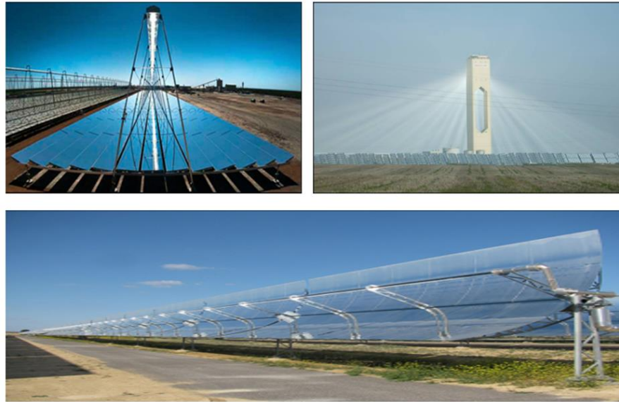
Figura 21. Tecnologías de concentración solar: linear Fresnel (izquierda), torre de concentración (derecha) y cilindros parabólicos (abajo).
