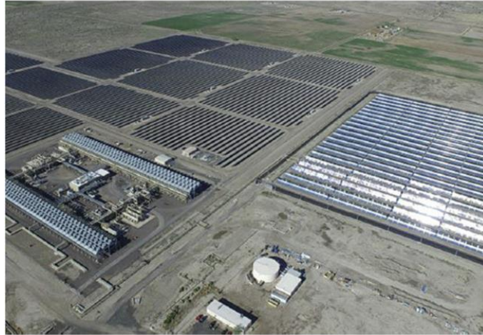
Figura 30. Vista aérea de la planta híbrida PV-CSP-geotermal Stillwater, en Nevada.
