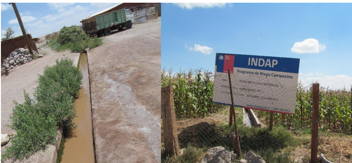
Ilustración 7 Izquierda: Canal Revestido. Derecha; Programa de riego Campesino INDAP. Revestimiento Canal Interpredial. Fuente: Fotografías trabajo en terreno
