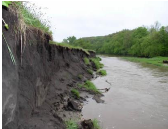
Figura 1: Erosión en las laderas debido a la falta de vegetación en la zona ribereña.
