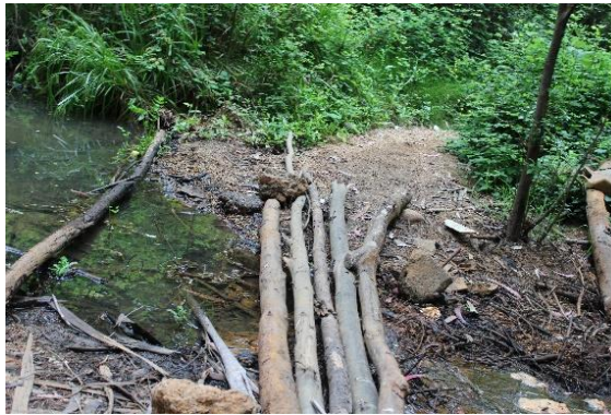
Figura 2 Leña como disipadora de energía del cauce, Quebrada Los Claveles
