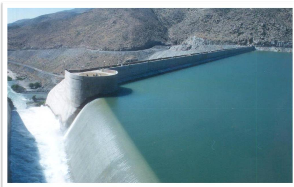
Fotografía 2 Embalse rebalsando sus aguas tras llenado en 1997
