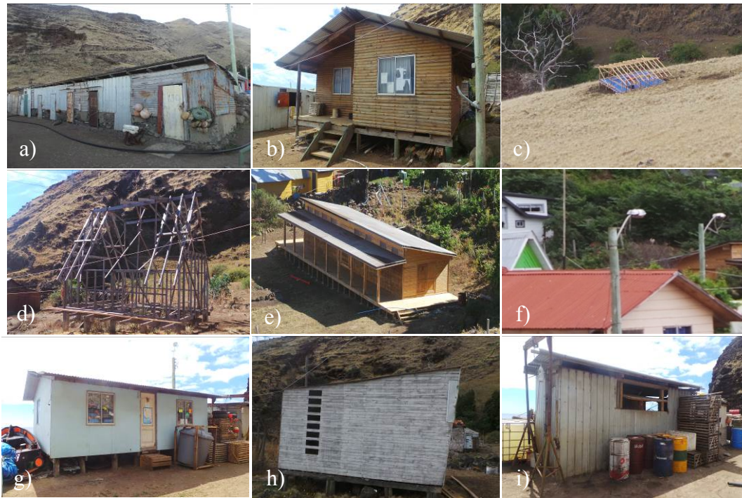
Figura 18. Registros fotográficos de la infraestructura social de IAS, siendo a) cuarto de pescadores, b) sede social, c) refugio para catástrofes, d) casa de huéspedes, e) escuela, f) alumbrado público, g) sala de faenamiento, h) capilla e i) sala de motor.
