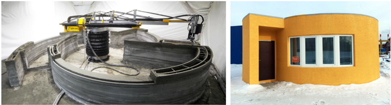
Figura 2.15: Impresora circular Apis Cor y construcción de una casa en Moscú 2016.
