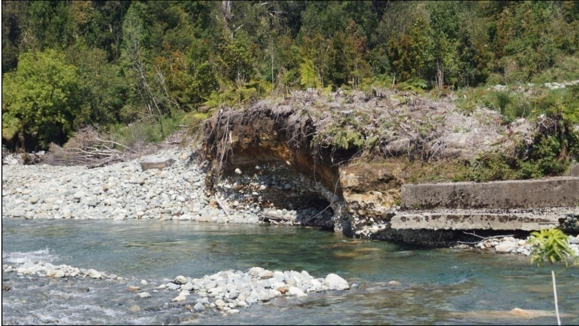
Figura 35: Sección de terraza cortada en el estero Troliguán, afluente del río Vodudahue, cuenca de Vodudahue.
