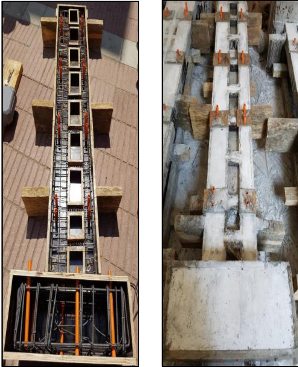
Figura 3.6. Izq) Moldaje y armadura de probeta 3; Der) Probeta 3 hormigonada (Santos, 2018)
