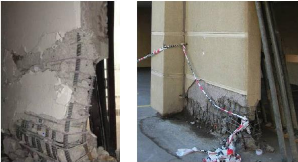
Figura 2.18. Inestabilidad lateral de muros. Izq) Pandeo global; Der) Pandeo local. (Tellen y otros, 2012)
