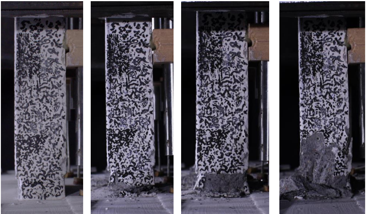
Figura 4.82. Registro de fotografías de la cara lateral del muro derecho. a) posición cero inicial; b) tracción en la deriva de techo 6,0%; c) compresión en la deriva de techo 6,0% - Probeta 1
