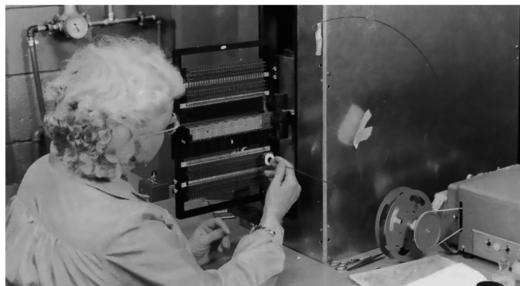
Fig. 16 Trabajadoras de la compañía Raytheon usando una “máquina de coser memorias” para ayudarse en su tarea (NASA).
