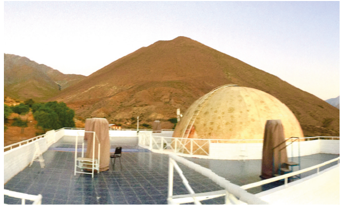
Figura 24: Terraza principal edificio Nicolás Copérnico. Fotografía propia.
