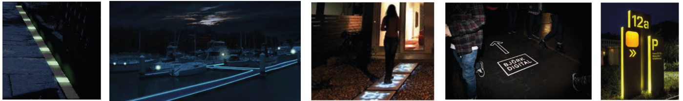
Figura 82: a) Iluminación nocturna discontinua de piso; b) Iluminación nocturna continua de piso; c) Iluminación nocturna de piso por pastelones; d) Señalética fluorescente de piso; e) Señalética iluminada tipo tótem.
